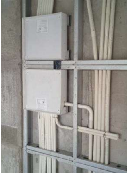
Fig. 9 Electrical conduits
